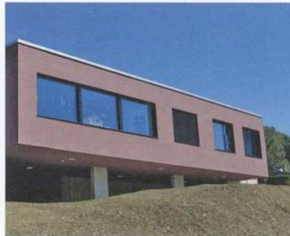
Der neue Kindergarten «Im Benze».
