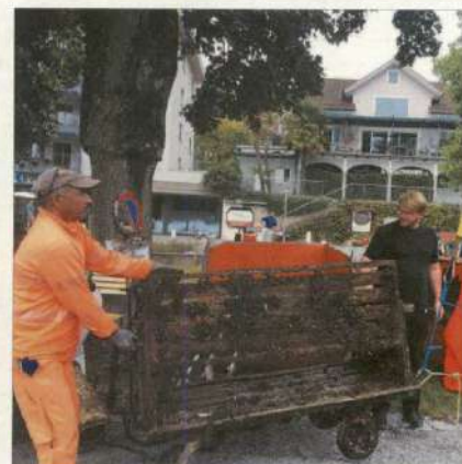
Ein alter Gepäckwagen wird gehoben.
